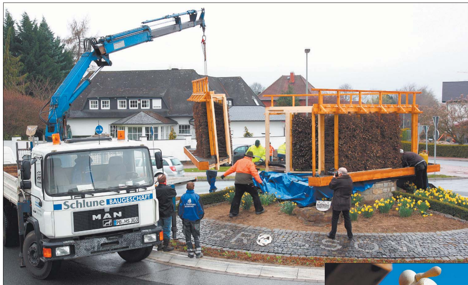
Das letzte der drei Elemente schwebt ein und wird eingepasst. Gut ein halbes Jahr lang wird das Dreieck-Gradierwerk jetzt den Kreisel Tudorfer Straße/Wewelsburger Straße zieren.
